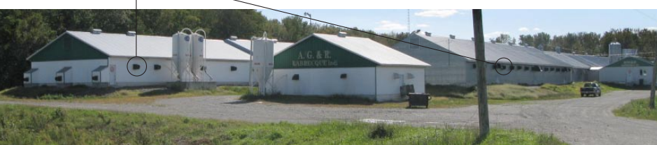
filtration de l'air entrant sur bâtiment au Québec
