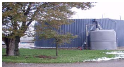
Petite unité de méthanisation Bio4gas (45 kW) fonctionnant exclusivement avec du lisier de porc
