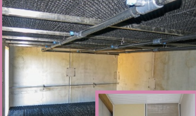
Le laveur d'air est calibré pour une vitesse d'air de 1 mètre par seconde permettant d'optimiser notamment le taux d'abattement de l'ammoniac. ©Ifip
