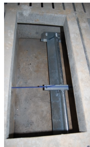
raclage des déjections sous caillebotis
